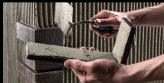
С уголками работают по методу двойного намазывания.
